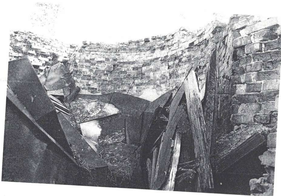
Обрушенные конструкции крыши и главы.
