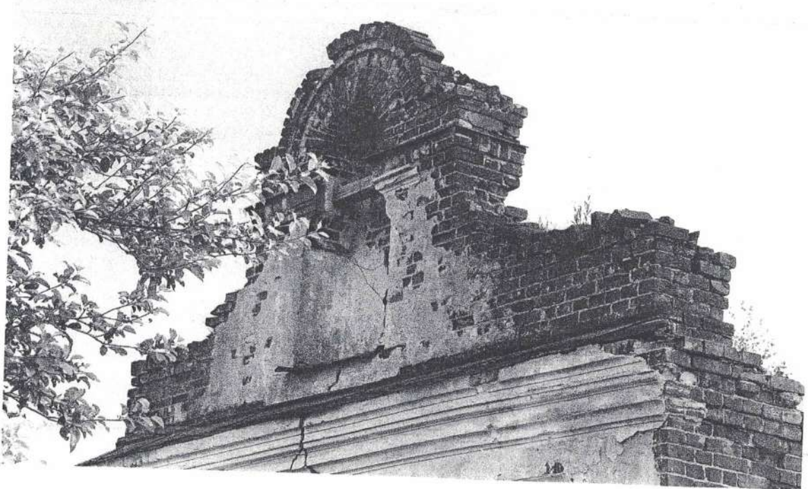
Фрагмент западного фасада.
