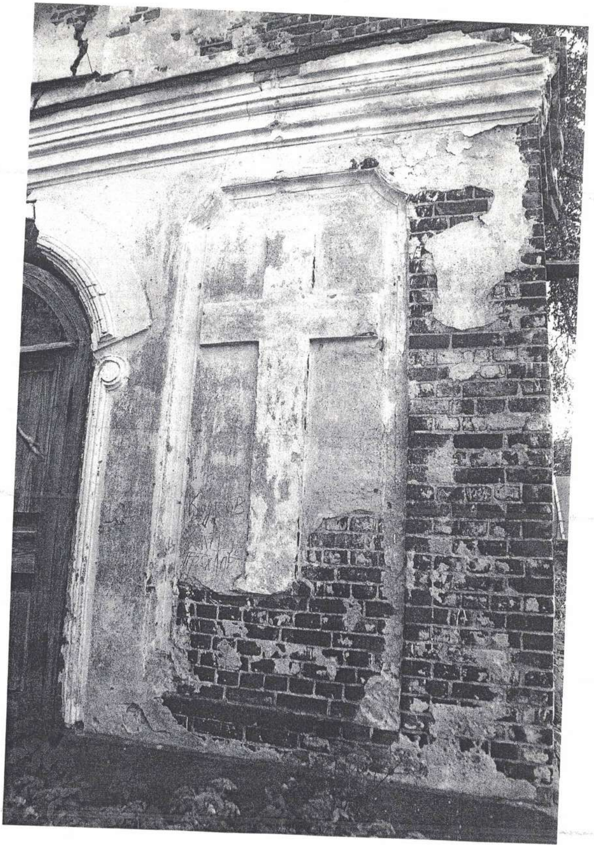
Декор западного фасада
