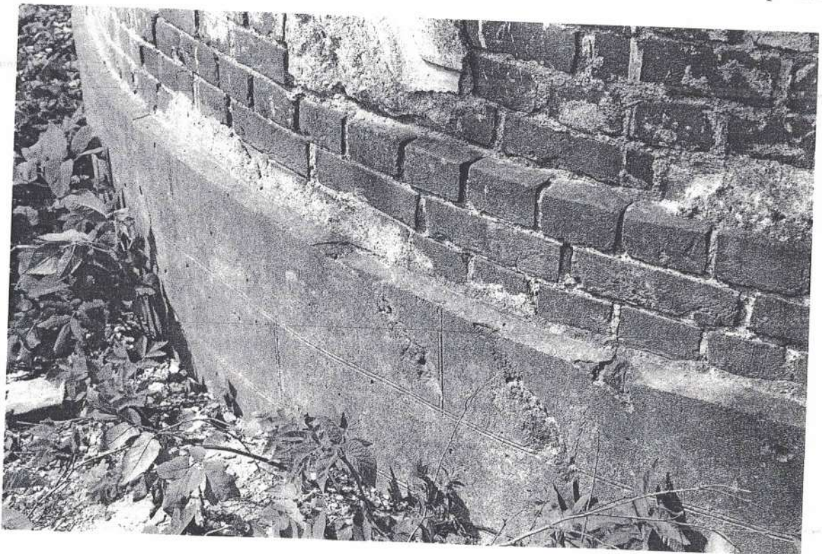
Фрагмент восточного фасада, цоколь.
